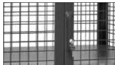
Treibriegelverschluss mit Schwenkhebel und Zylinderschloss.
